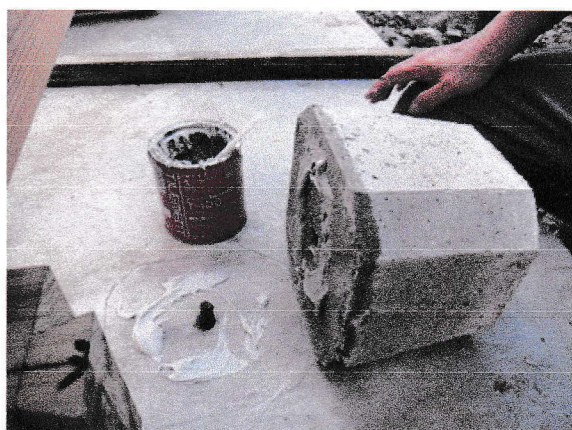
写真 4 : コンクリートボンドによる接着
