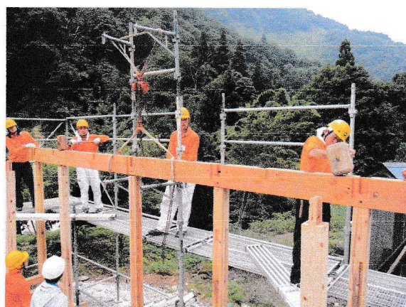
写真 5 : 軒桁組み
